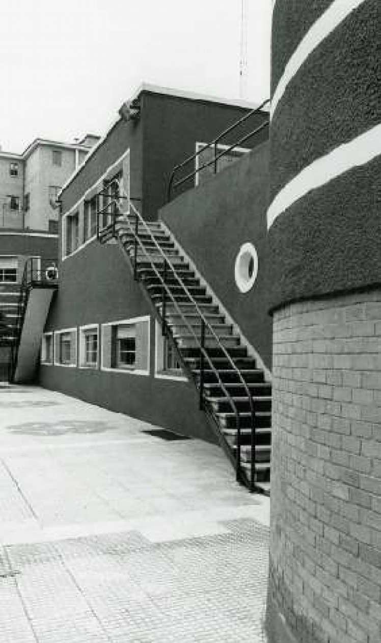
Oficinas de la refinería de aceites Hipsa, 1935-1936 Constantino Candeira, arquitecto García Morato 11, Valladolid
