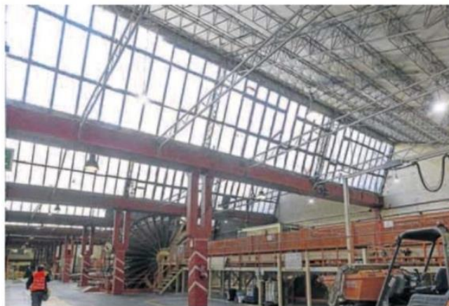
Una de las naves levantadas sobre pilares de hormigón que sustentan un lucernario. ALBERTO MINGUEZA
