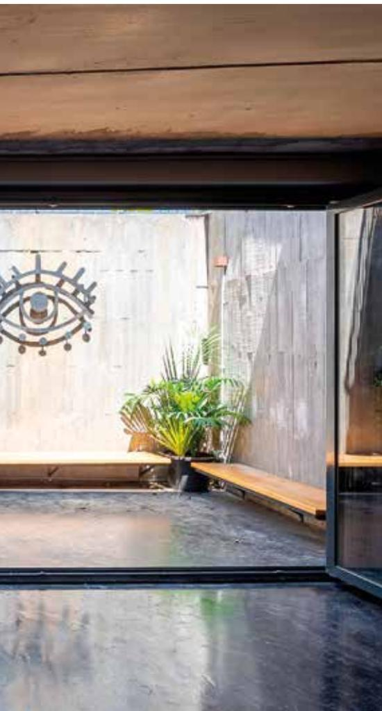
En el interior se han dejado vistos los muros de contención laterales y la cara inferior de las placas aligeradas de once metros de luz que forman el forjado del espacio diáfano principal, así como la estructura de la escalera, con sus texturas, recalcando la sinceridad material que se pretendía en este espacio.
